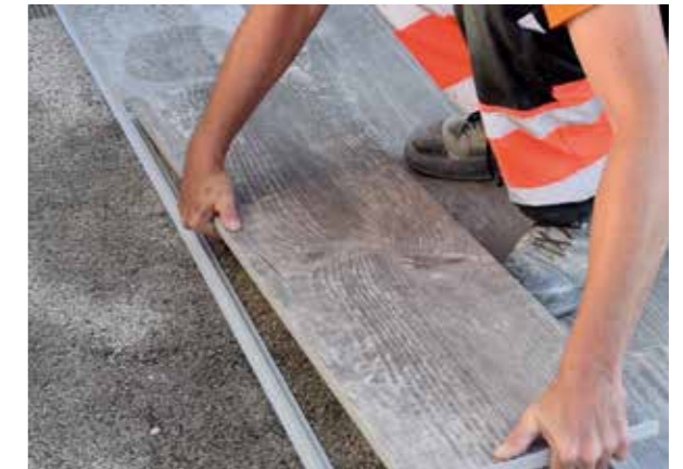
Kein Wippen dank durchgehende Auflage der Plattenkante.
