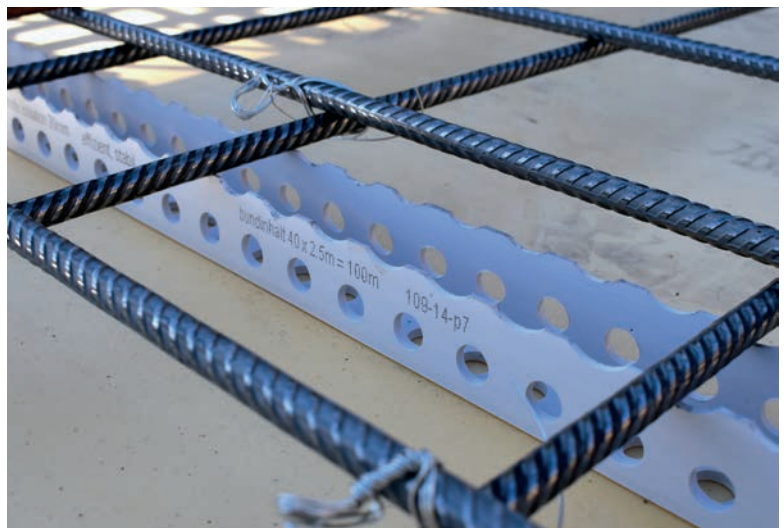
ferrofix isolation verteilt das Gewicht gleichmässig und hält die Eisen mit Rasterkerben.
