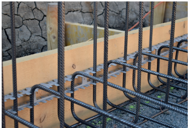
ferrofix wand hält vertikale Eisen mit nur einer Profilstange pro 1m Höhe.
