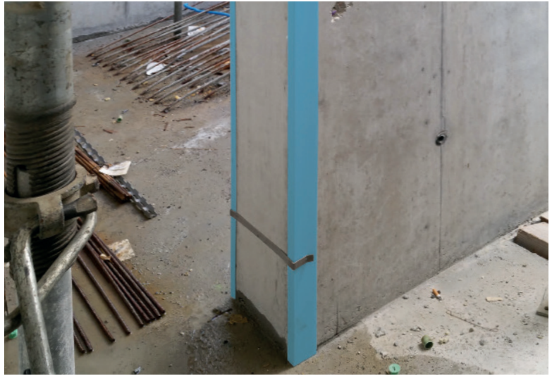
L'arête de béton de parement derrière la cornière de protection en PVC est parfaitement protégée.
