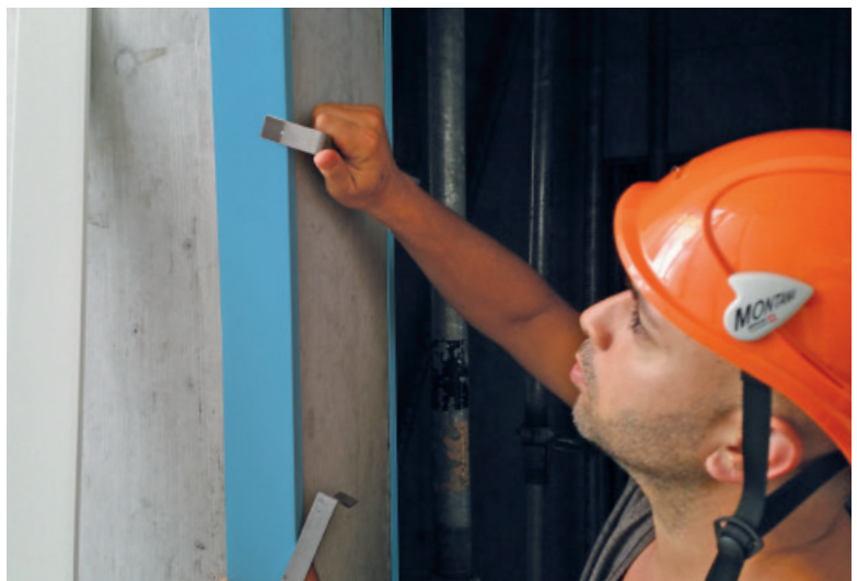
Les cornières sont fixées rapidement avec les pinces de serrage.
