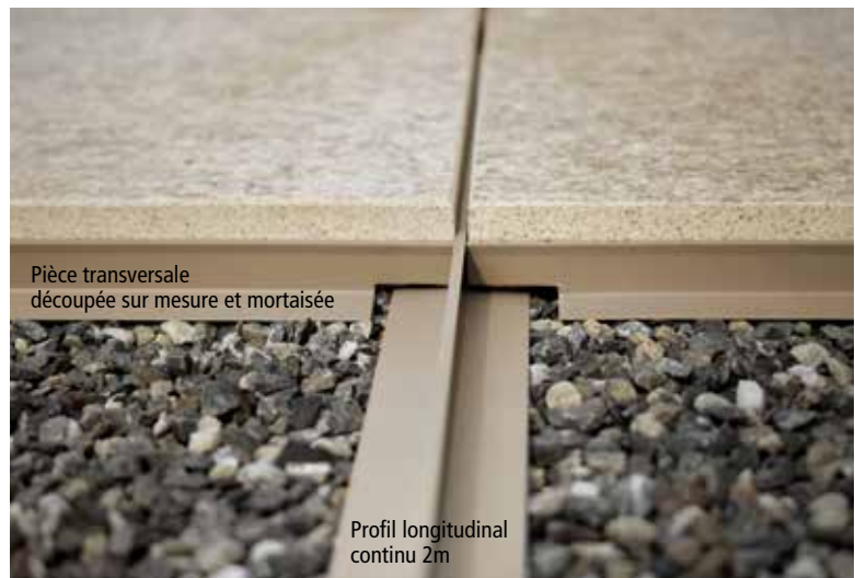
Présentation discrète des joints. Grâce au profil remplissant les joints, presque pas de joint d'ombre.
