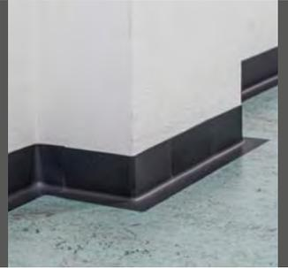
Ein System von Sockel- und Eckprofilen verbindet den Bodenbelag entlang der Kante fugenlos mit der Wand. Der L-förmige Sockel wird mit dem Belag bodenbündig verschweisst und erfüllt damit auch höchste hygienische Ansprüche im Spitalwesen. Geeignet für PVC, Kautschuk und Linolbeläge
