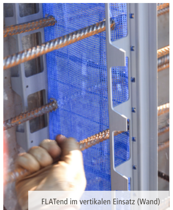
Rissfestes Netz reduziert den Rückfluss von Bojake
