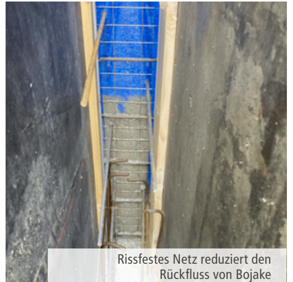
Auch bei Installationsdurchführungen kein Aufreißen des Netzes
