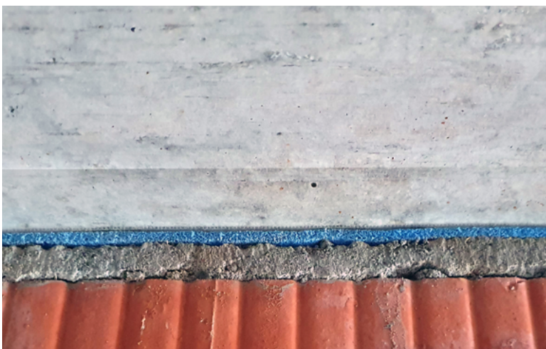
Deckenlager bleibt frei und muss nicht mühsam freigespitzt werden.
