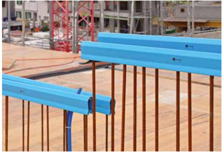
Keine Gefahr dank einfach aufgesetztem ferrotop.
