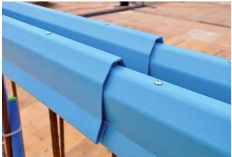
Überlappungen sind kein Problem und erhöhen die Sicherheit.
