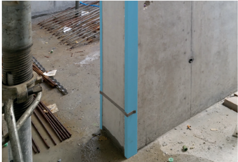
Die Sichtbetonkante hinter dem PVC-Kantenschutzwinkel ist sicher geschützt.
