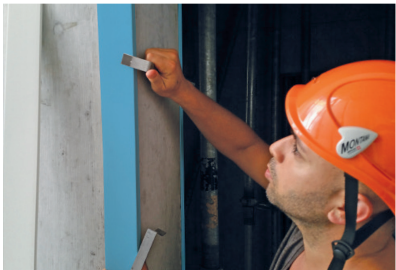
Die Winkel sind mit den Spannklammern schnell befestigt.
