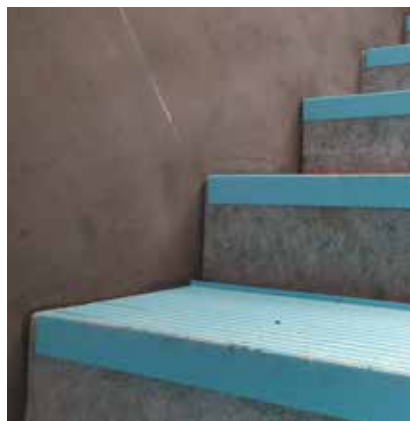
Treppenschutzwinkel befestigt mit Kantholz.
