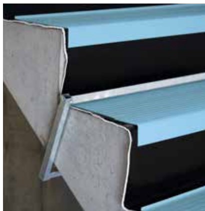
Befestigung der Treppenschutzwinkel mit Bügeln.
