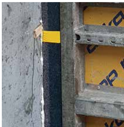
Flickstück zwischen Schalungselementen
