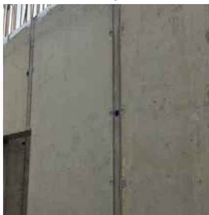
Flickstück zwischen Schalungselementen
