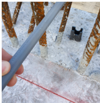
Nach dem Anzeichnen Stab einklicken.
