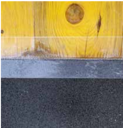
Das Lagerband ist doppelt perforiert. Die eine Seite klebt an der Schaltafel, die andere hält am Deckenlager.
