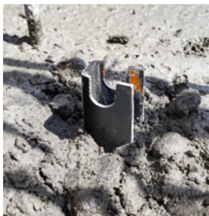
U-Profil in Frischbeton stecken.
