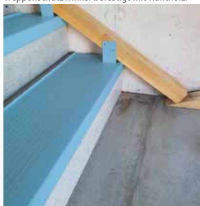
Treppenschutzwinkel befestigt mit Kantholz.
