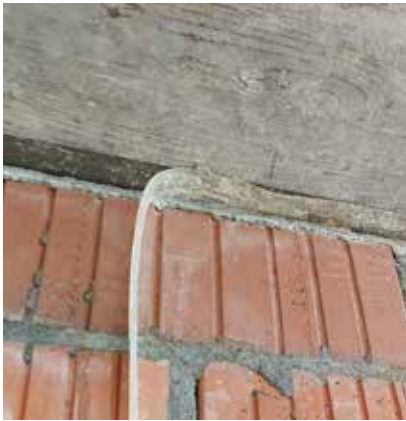
Lagerband abreißen nach dem Ausschalen
