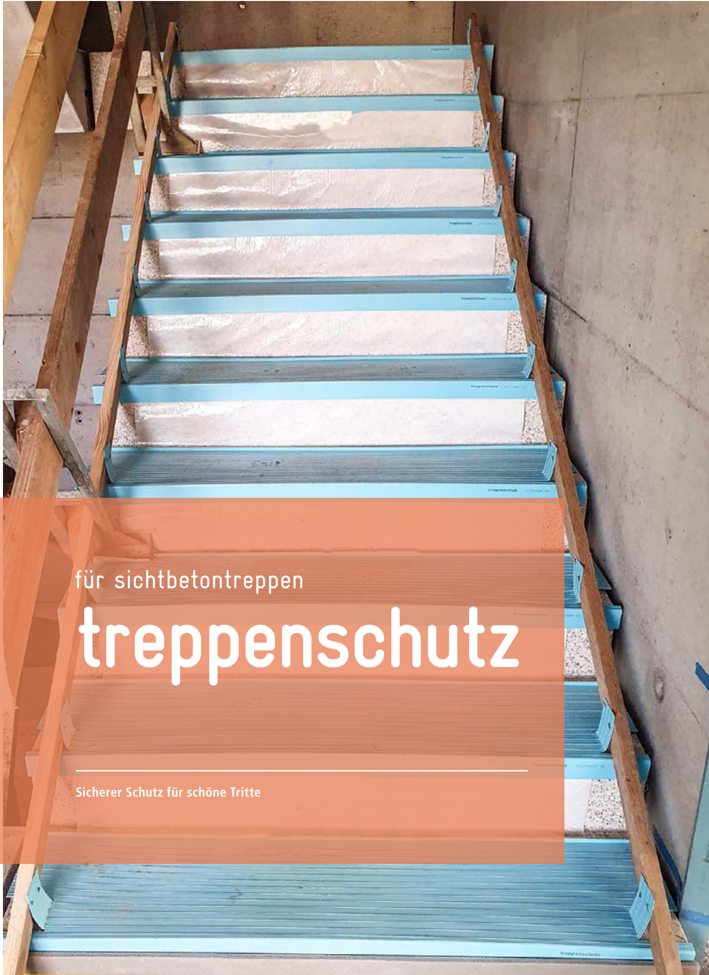
Verbindung der Treppenschutzwinkel mit einem Kantholz
