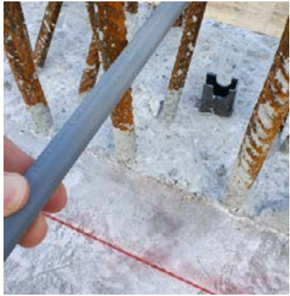
Nach dem Anzeichnen Stab einklicken.
