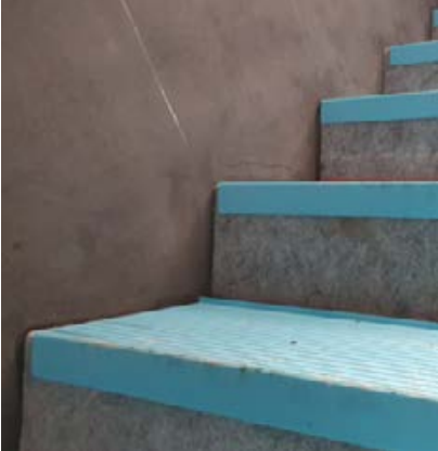
Treppenschutzwinkel befestigt mit Kantholz.
