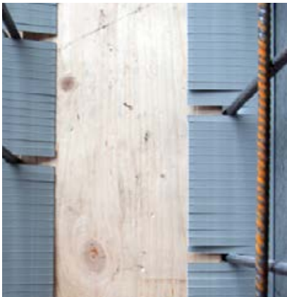
ferrofix kamm funktioniert auch bei Wand-Etappen
