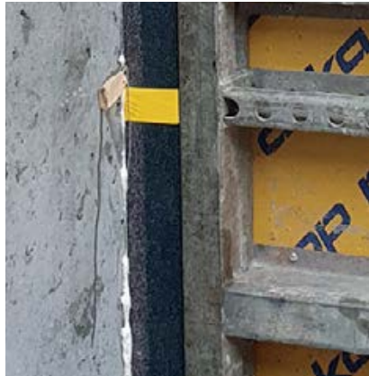
Flickstück zwischen Schalungselementen
