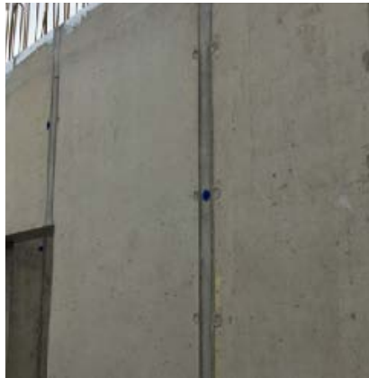
Flickstück zwischen Schalungselementen
