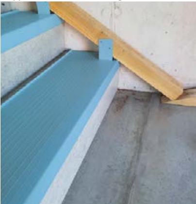
Treppenschutzwinkel befestigt mit Kantholz.
