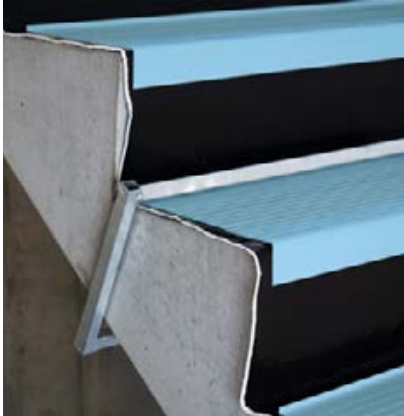
Befestigung der Treppenschutzwinkel mit Bügeln.
