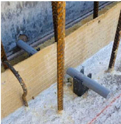
Einsatz mit Fugenband
