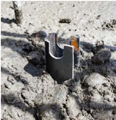
U-Profil in Frischbeton stecken.
