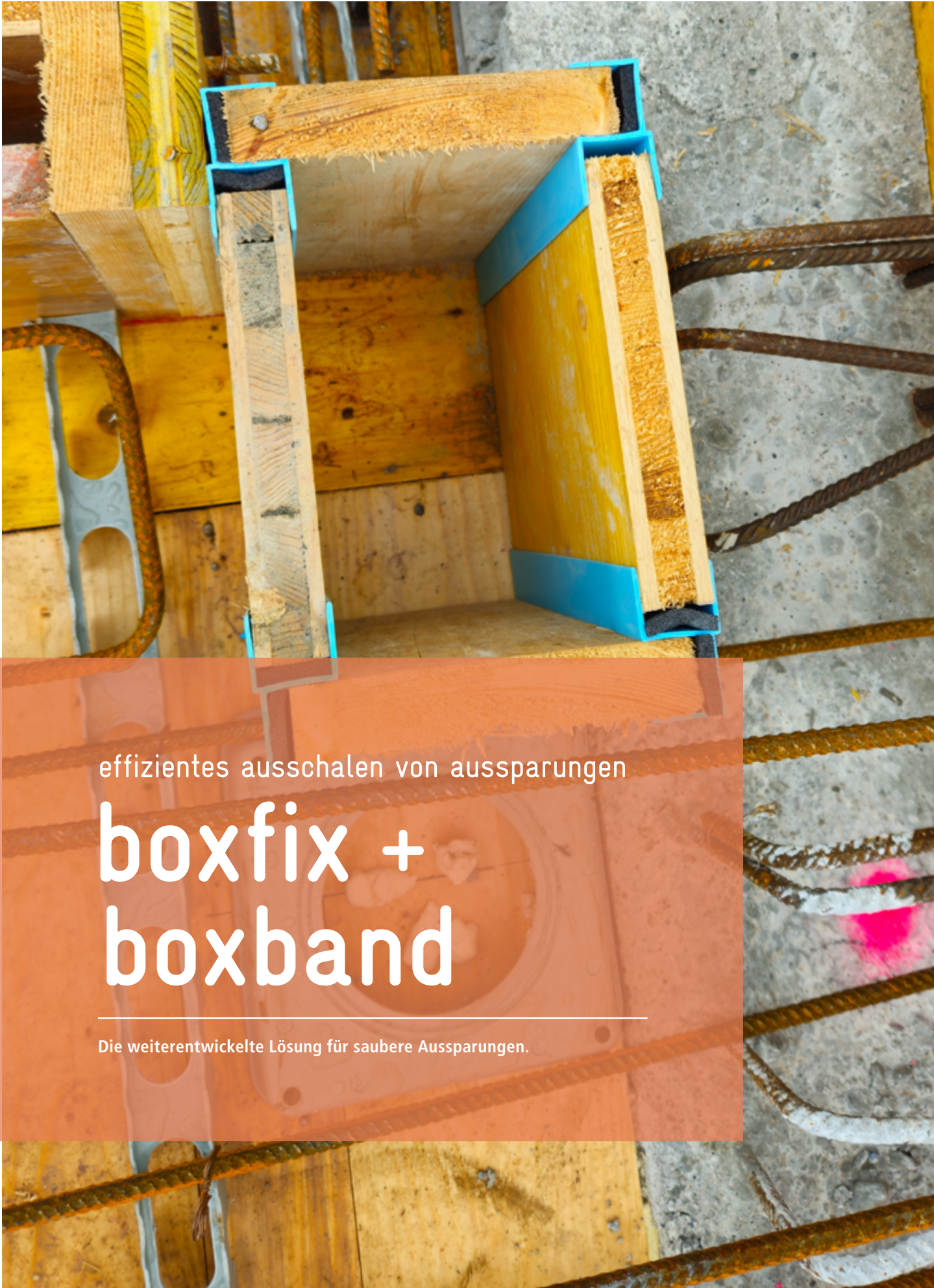
Aussparungsrahmen einfach zusammenstecken
