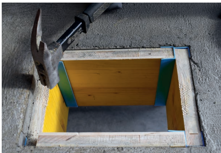
Les planches peuvent être décoffrés individuellement.
