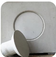
Cône pour béton apparent 22/10, presque à fleur
